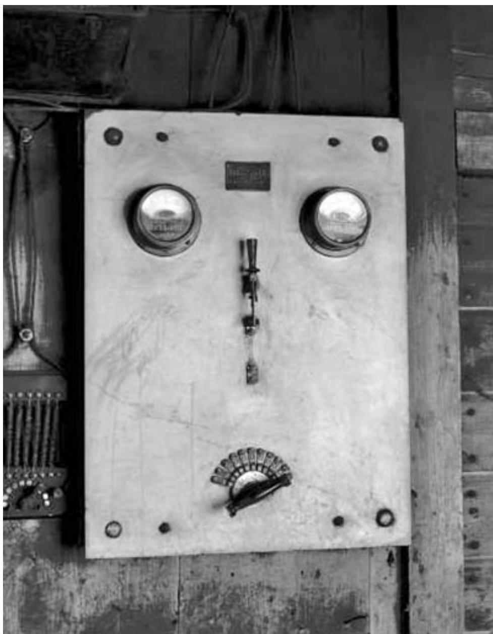
Intérieur : tableau de contrôle Grauer et Weil.
