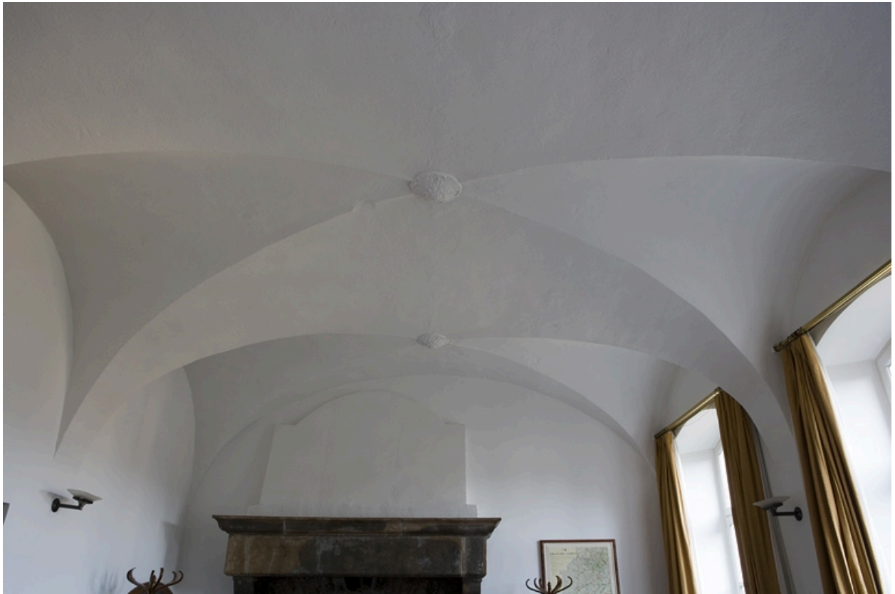
Intérieur : détail des voûtes d'arêtes de l'ancienne cuisine.
