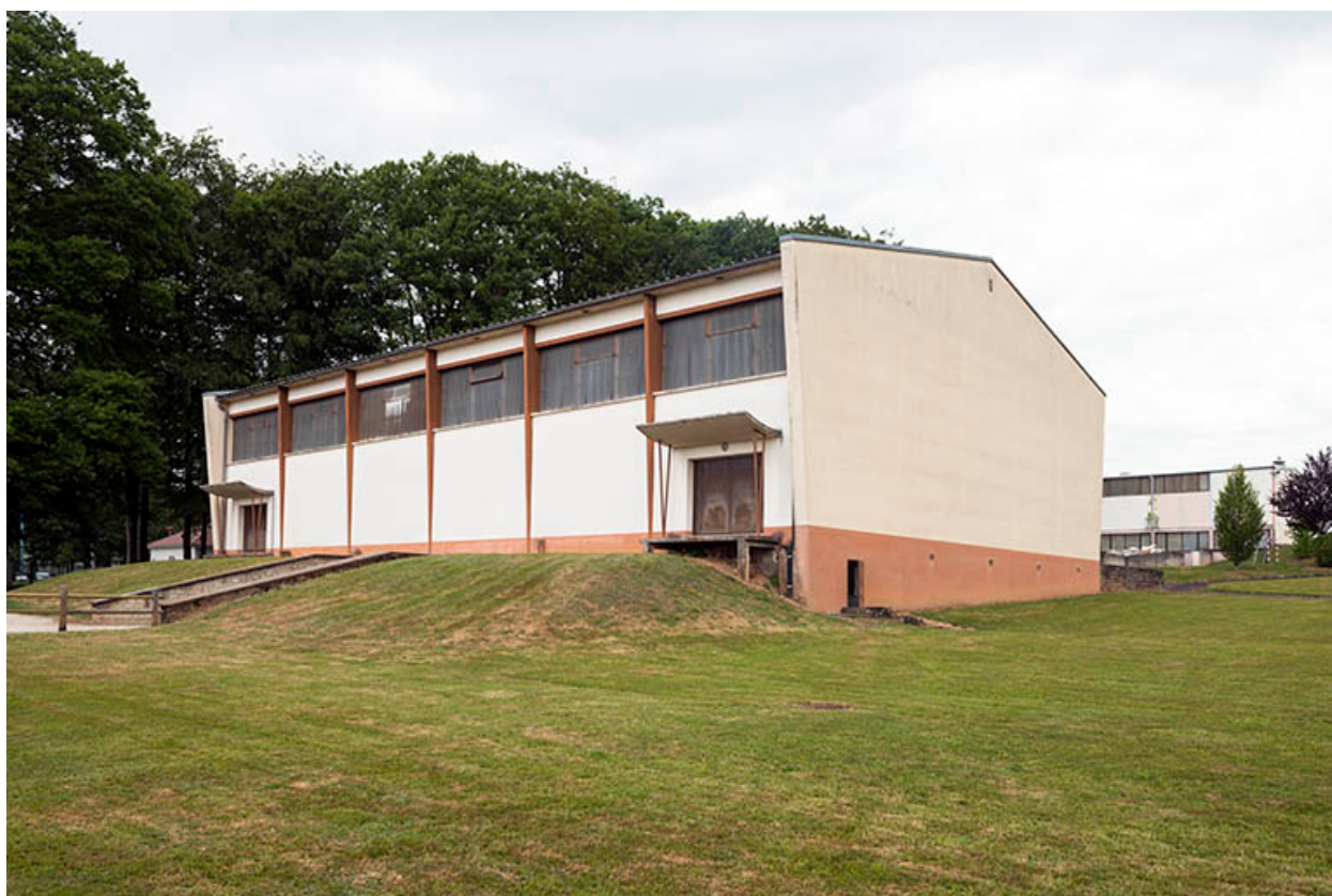
Gymnase : vue postérieure.
