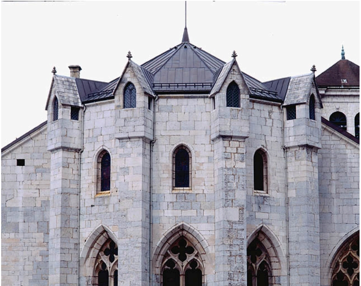
Vue des 4 échauguettes de l'abside.
