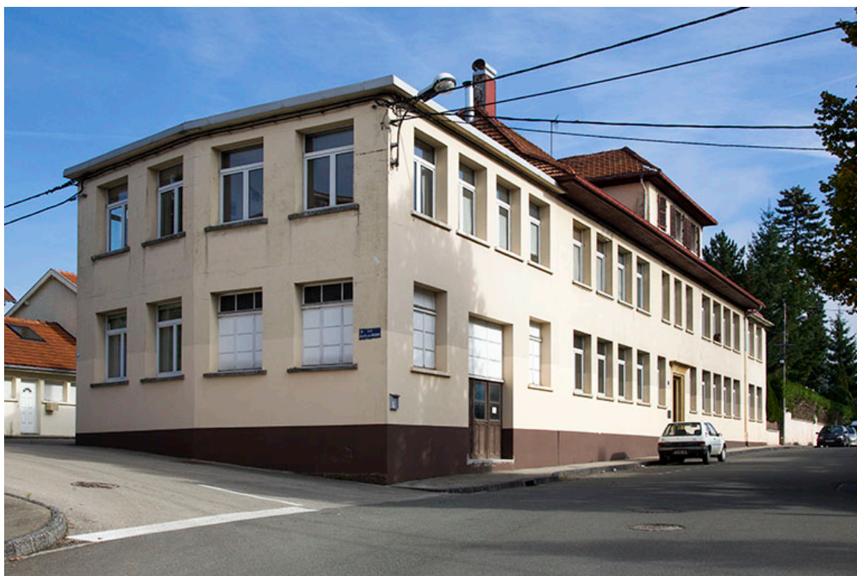
Usine : façade antérieure, de trois quarts gauche.
