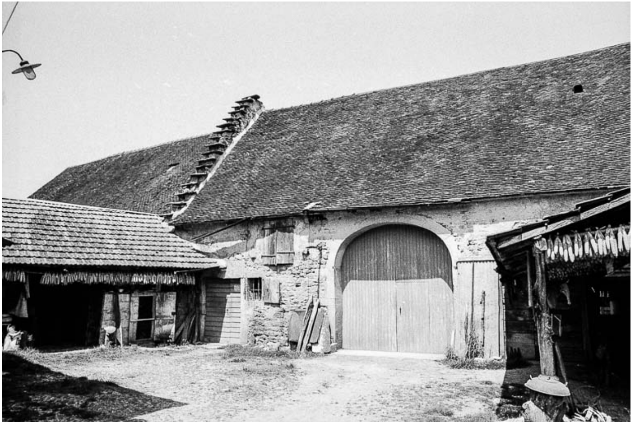
Fermes situées 324-326 rue d'Oisenans : bâtiments d'exploitation.
