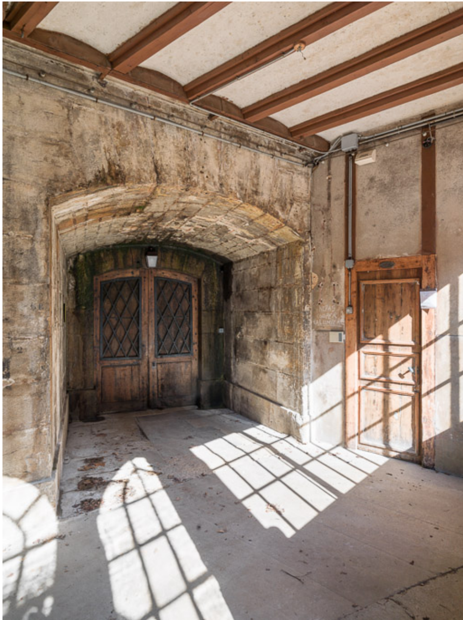
Entrée de la tour, rez-de-chaussée : vue de trois quarts gauche.
