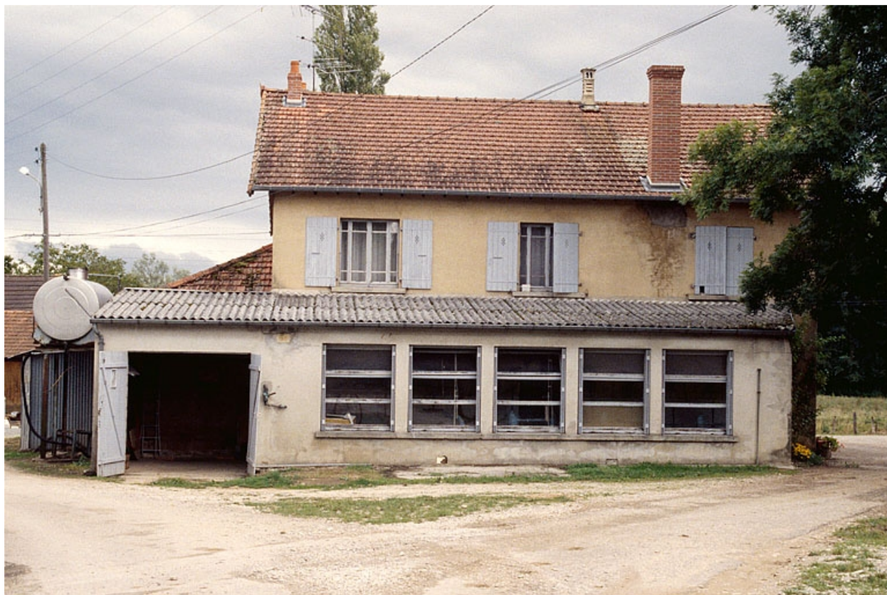
Façade latérale depuis le nord.
