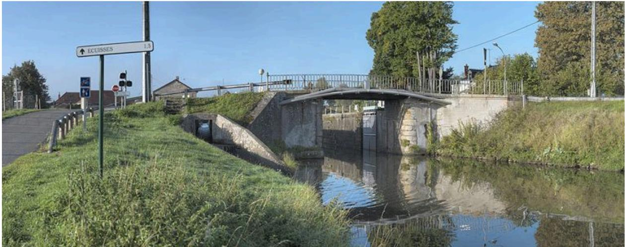
Le site d'écluse 05 vu du bief 06. Pont sur écluse avec escalier. Arrivée de la rigole régulatrice des biefs.
