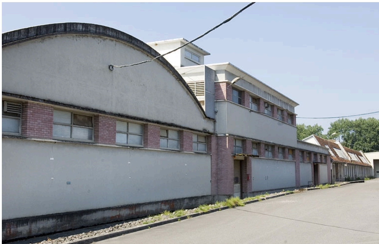
Façade nord de l'atelier de filature.
