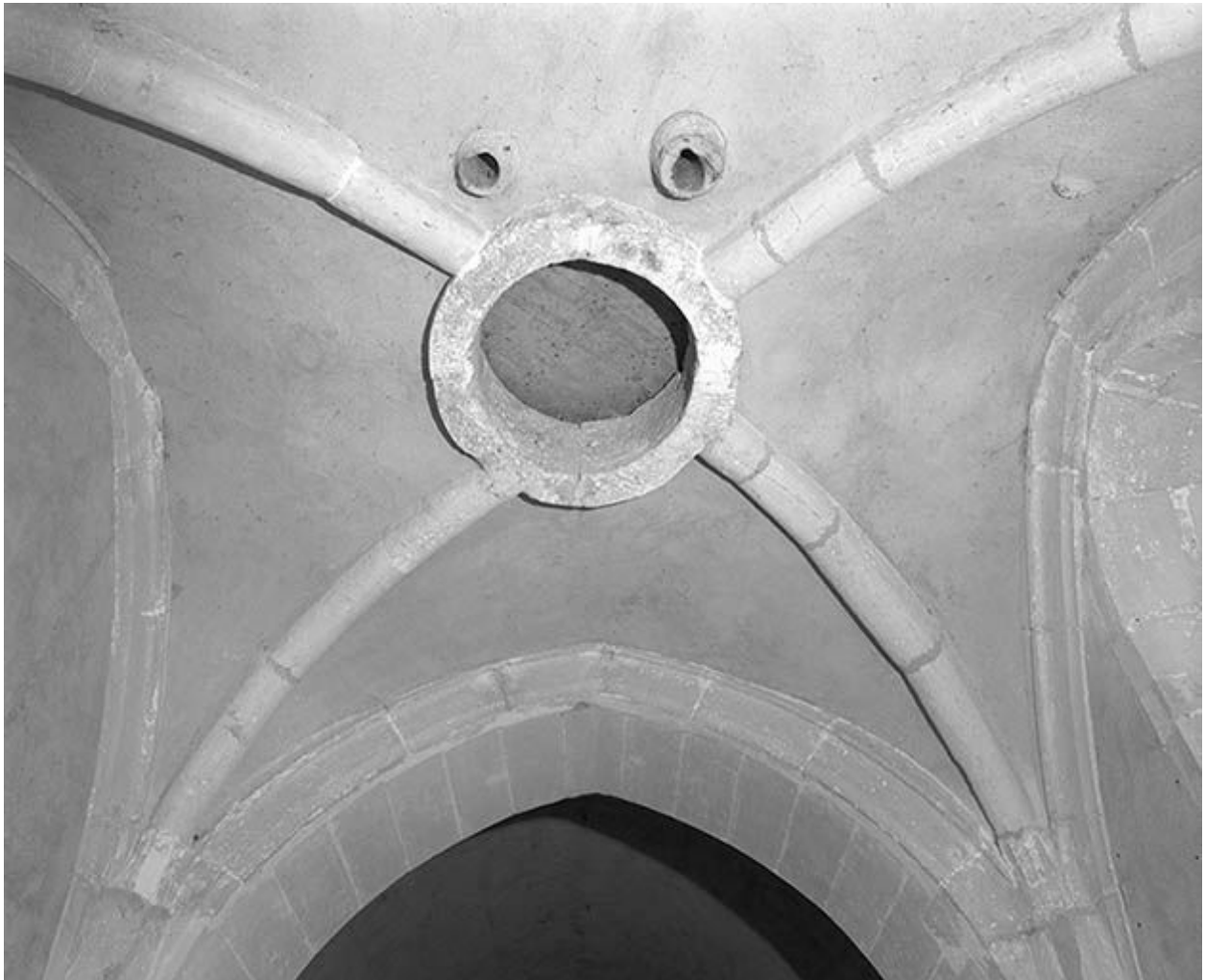
Voûte du vestibule.
