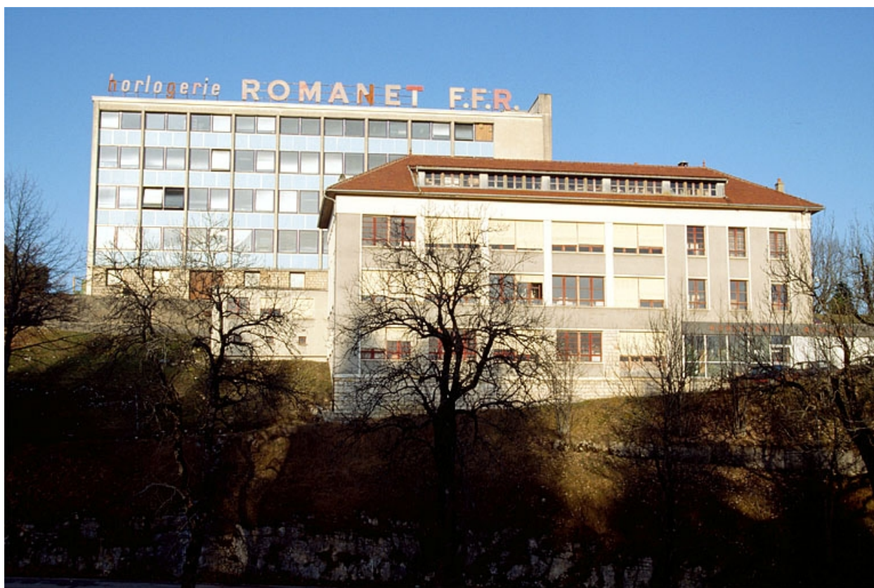
Façade antérieure des bâtiments.
