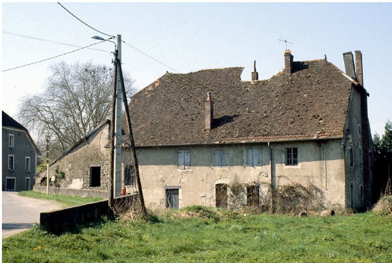
Façade antérieure du logement patronal (I).
