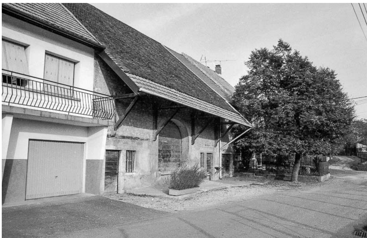
Arbouans : ferme située 3 rue des Roches.
