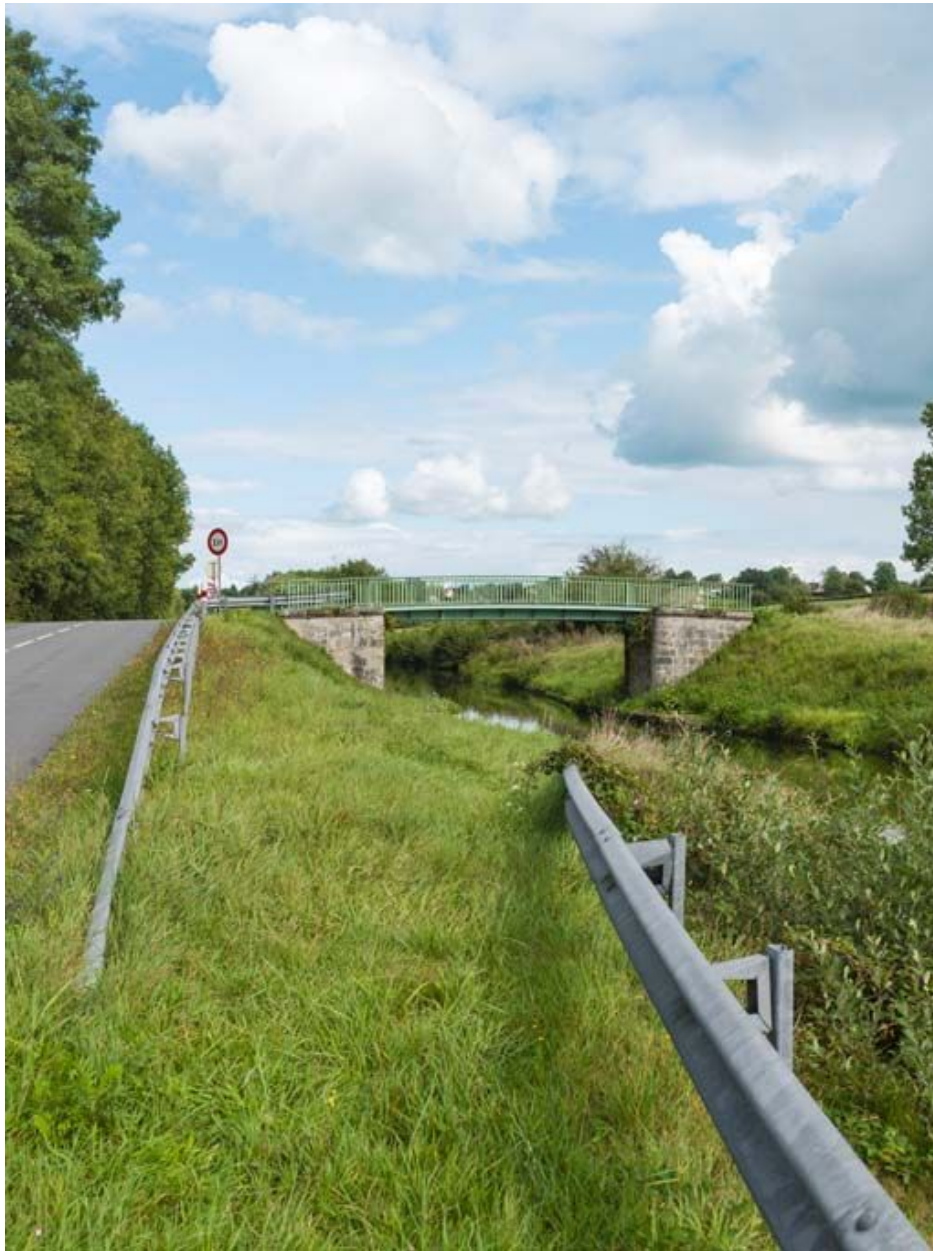
Vue d'ensemble du pont.
