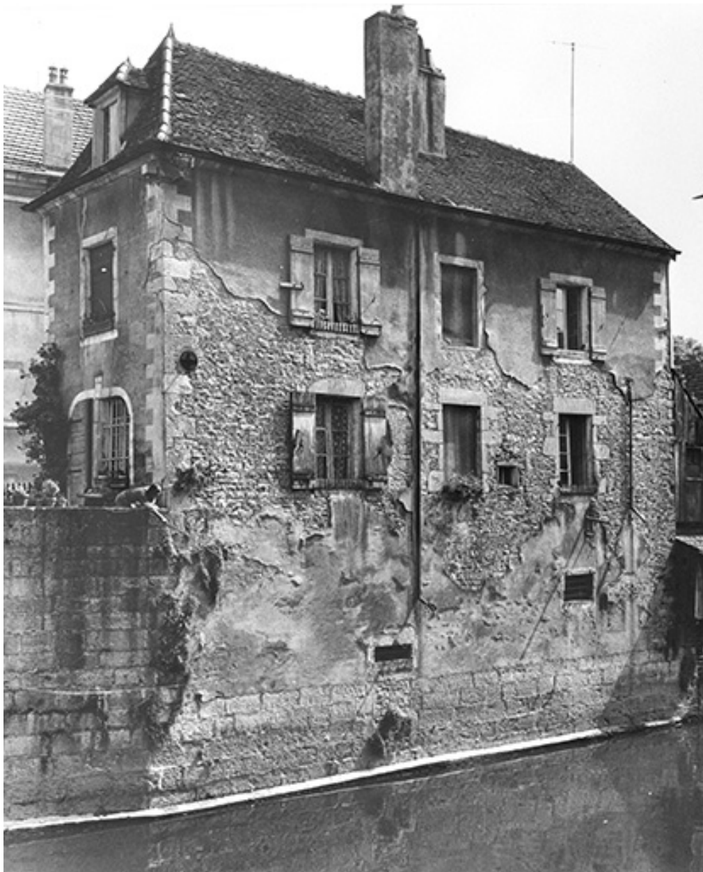
Façade postérieure de la maison datée 1780.
