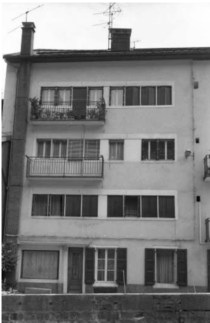
Détail de la façade latérale gauche.
