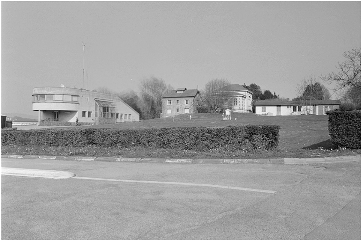
Partie nord : vue d'ensemble depuis l'ouest.
