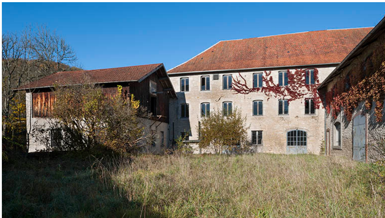
Façade sud de l'atelier.
