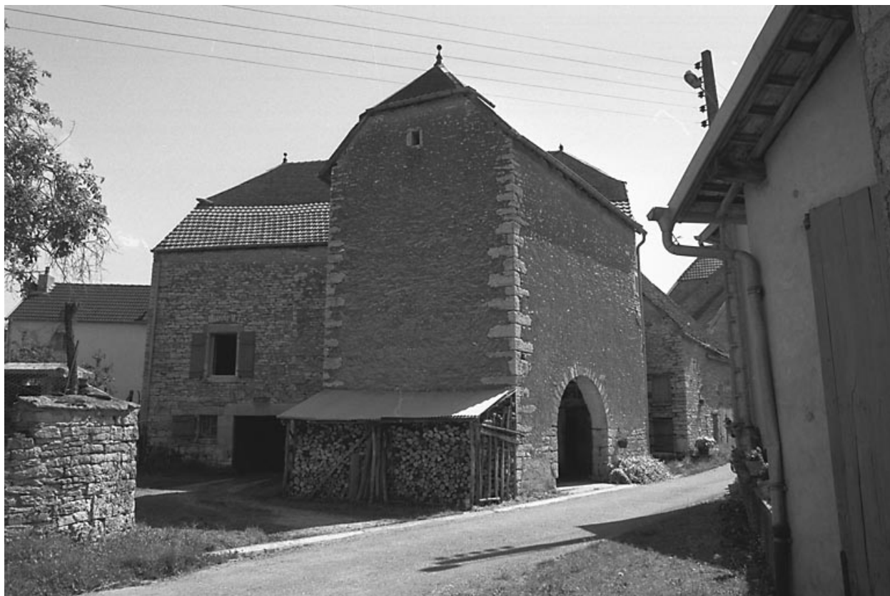
Façade postérieure du bâtiment.
