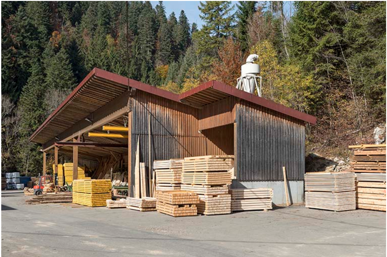
Ateliers à l'ouest.
