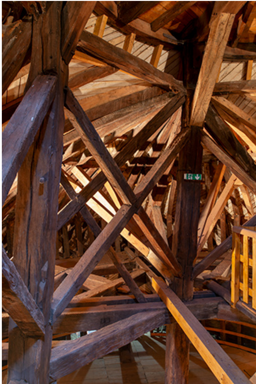
Entretoise du niveau intermédiaire, côté nord.
