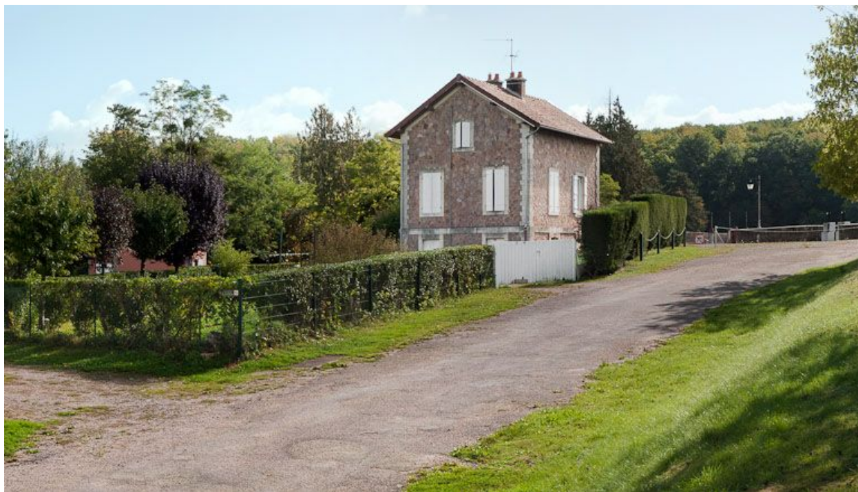
Vue de la maison de garde.
