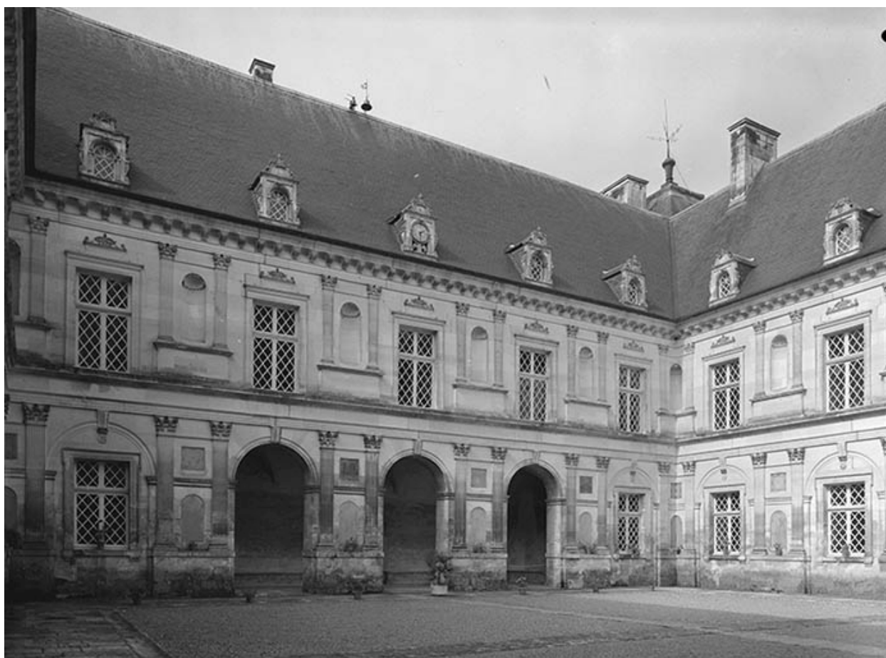
Façades sur cour (sud et ouest).
