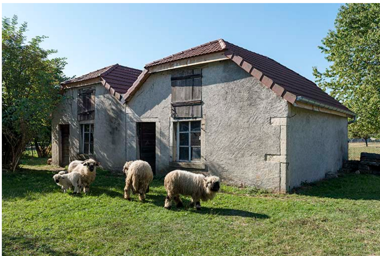
Forges : façade antérieure, de trois quarts droite.
