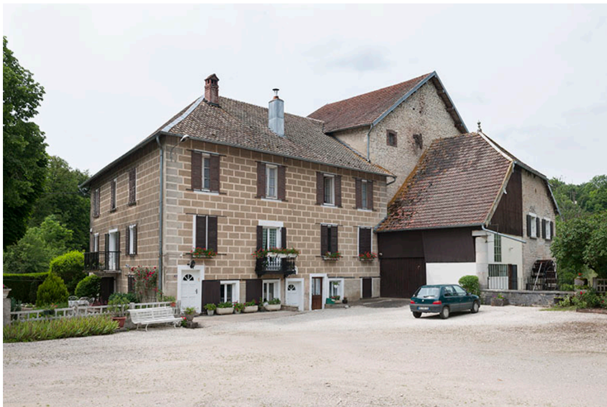
Logement et moulin depuis la cour.
