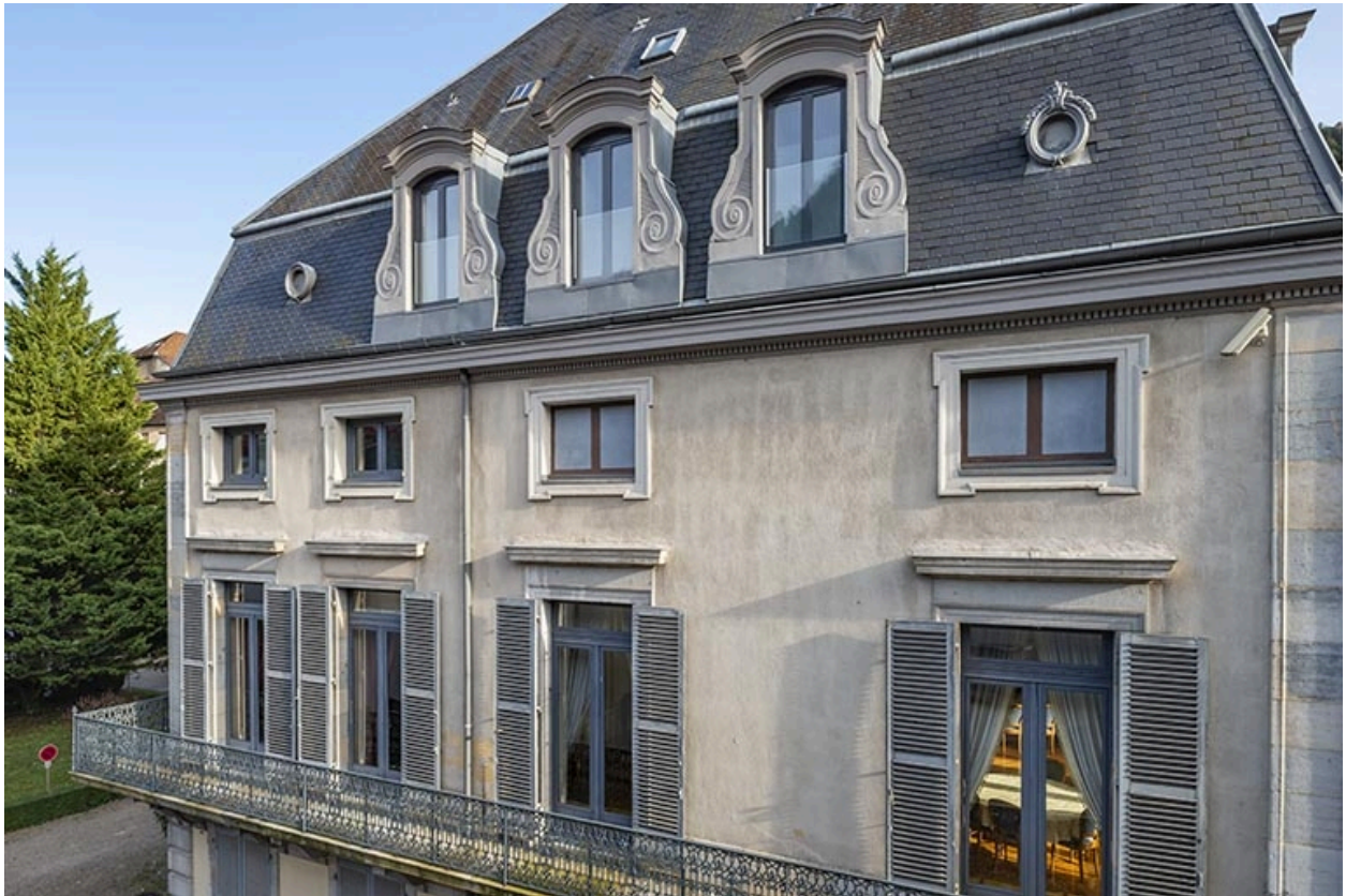
Façade ouest, détail.
