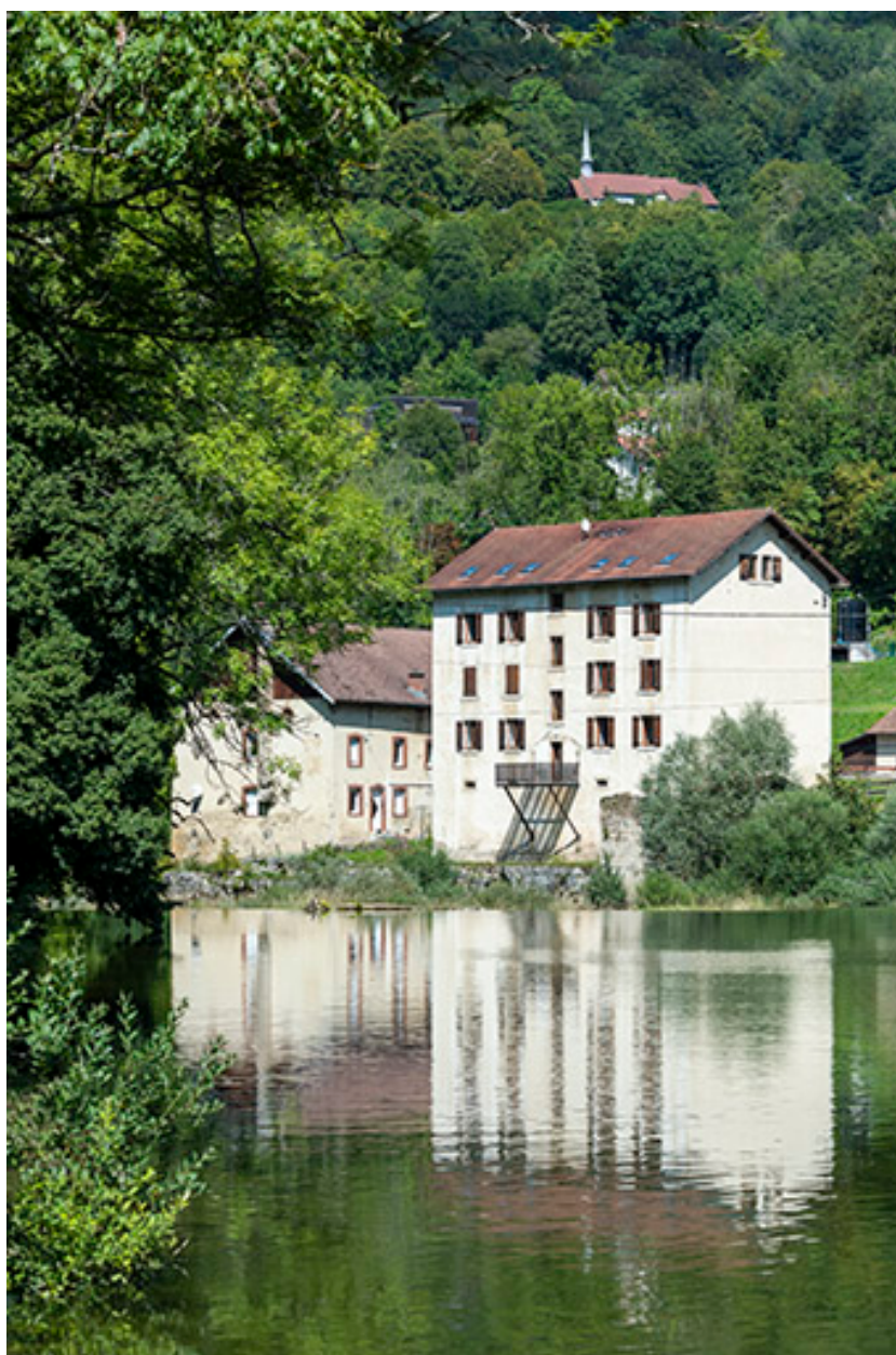
Façades postérieure et latérale gauche.
