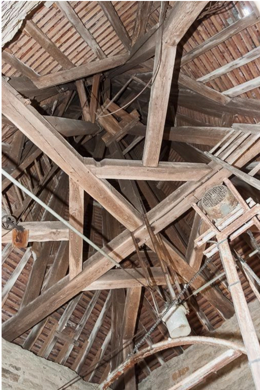
Charpente de la flèche du clocher.
