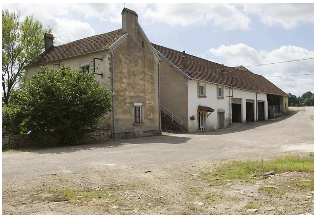
Logement et halle à charbon (remaniée).
