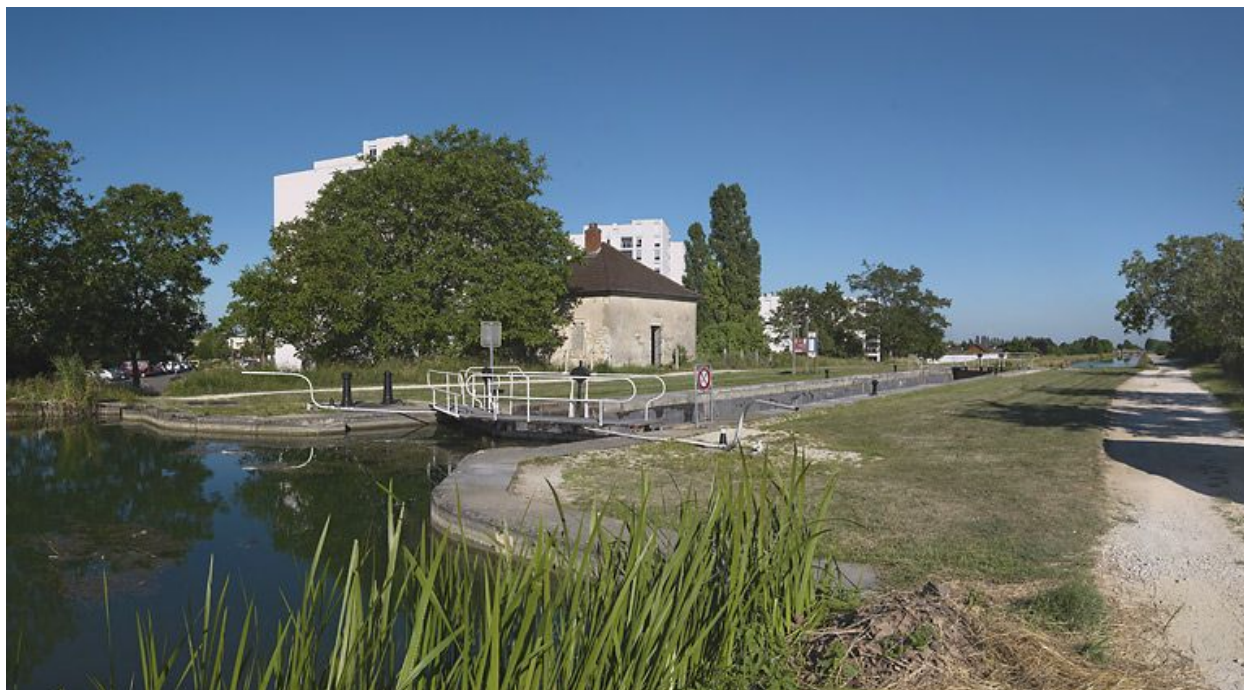
Vue d'ensemble du site, pris d'amont.
