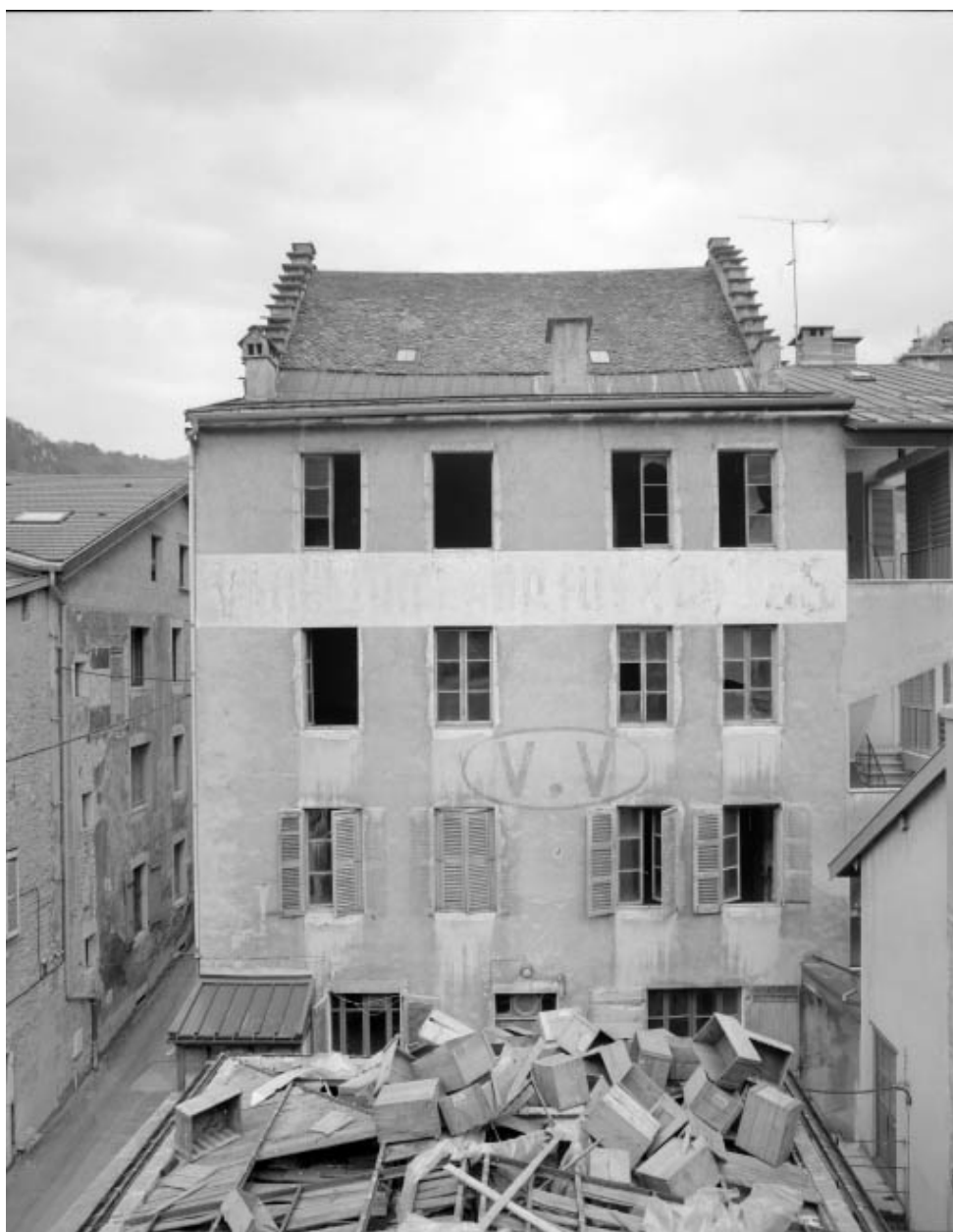
Immeuble : façade postérieure.
