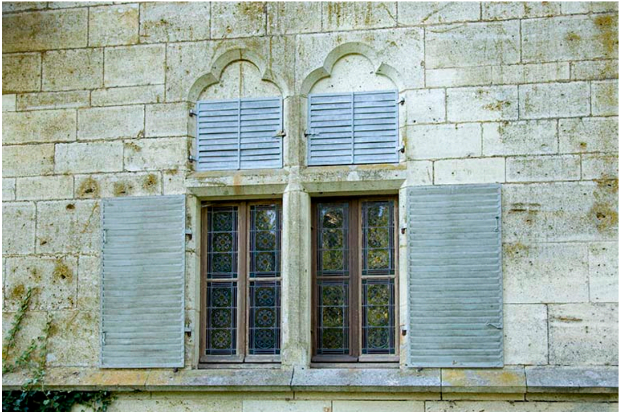
Détail : baies jumelées du 1er étage.
