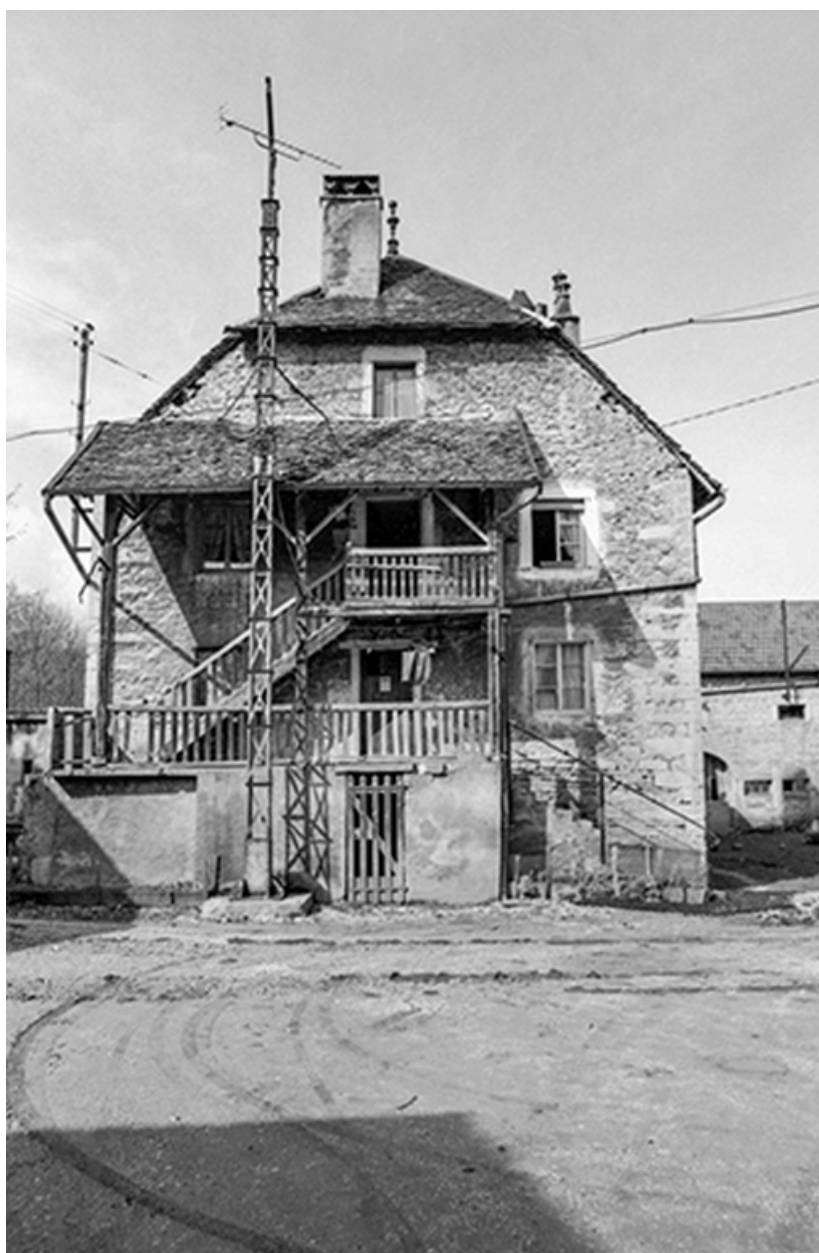
Mur-pignon du moulin (converti en logement ouvrier) en 1979.
