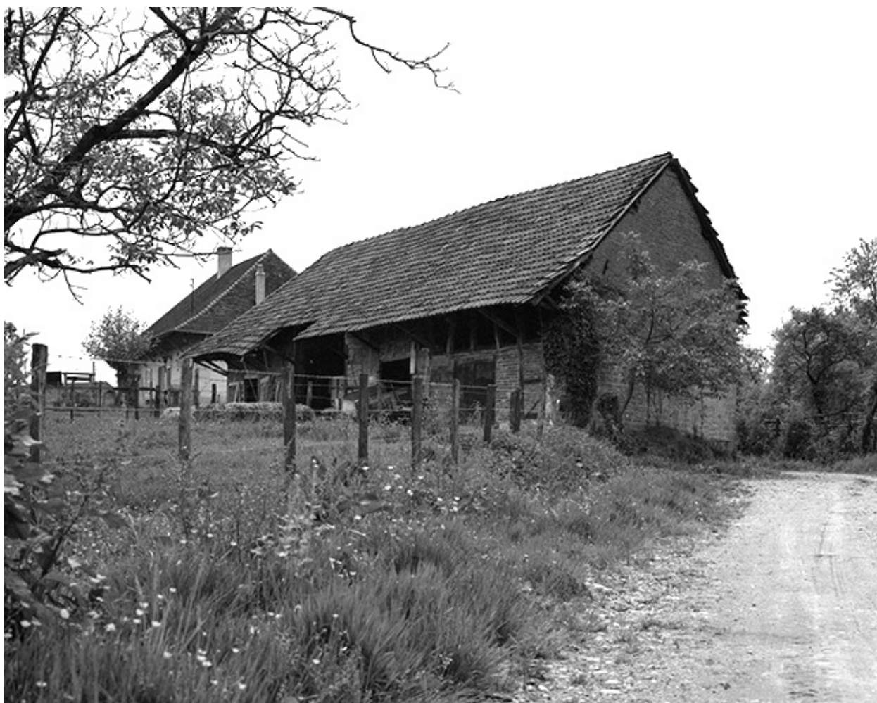
Bâtiment d'exploitation : façades antérieure et latérale droite.
