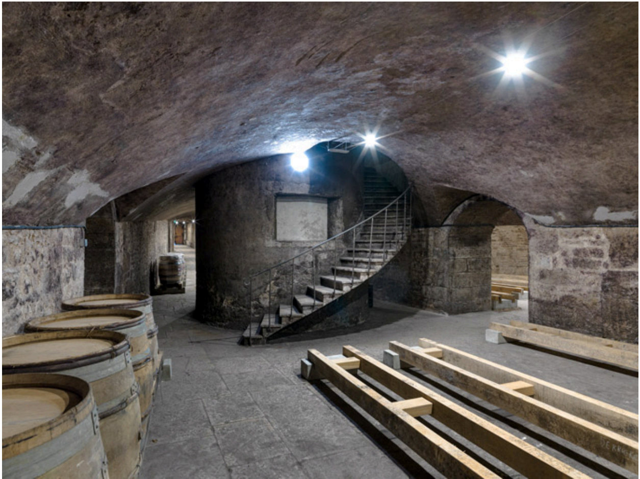
Caves, rez-de-chaussée : vaisseau central et le monte-charge.
