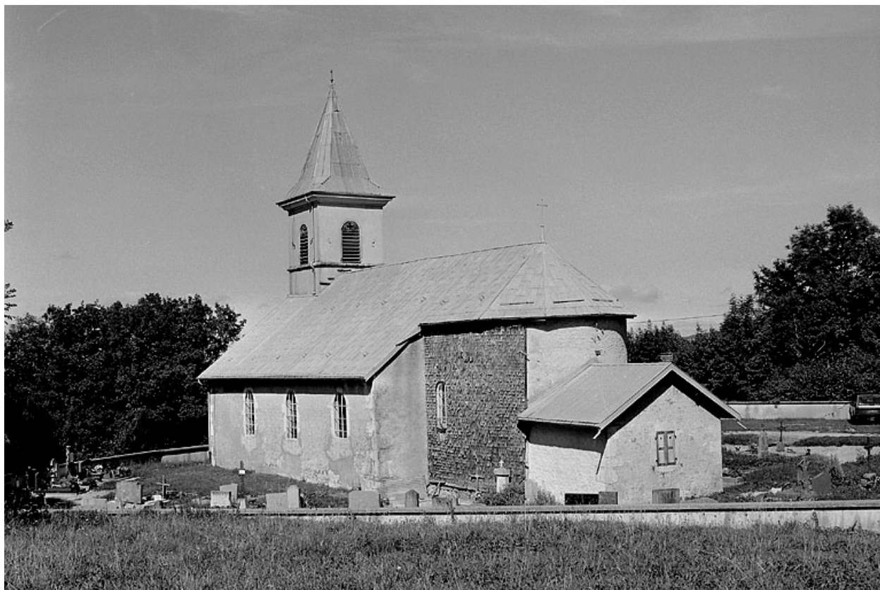
Extérieur : abside et face sud.
