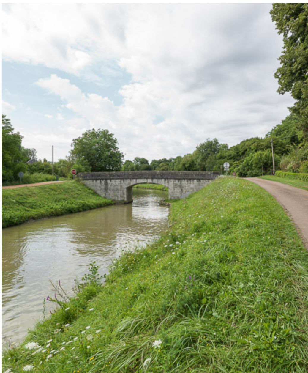
Vue d'ensemble du pont.
