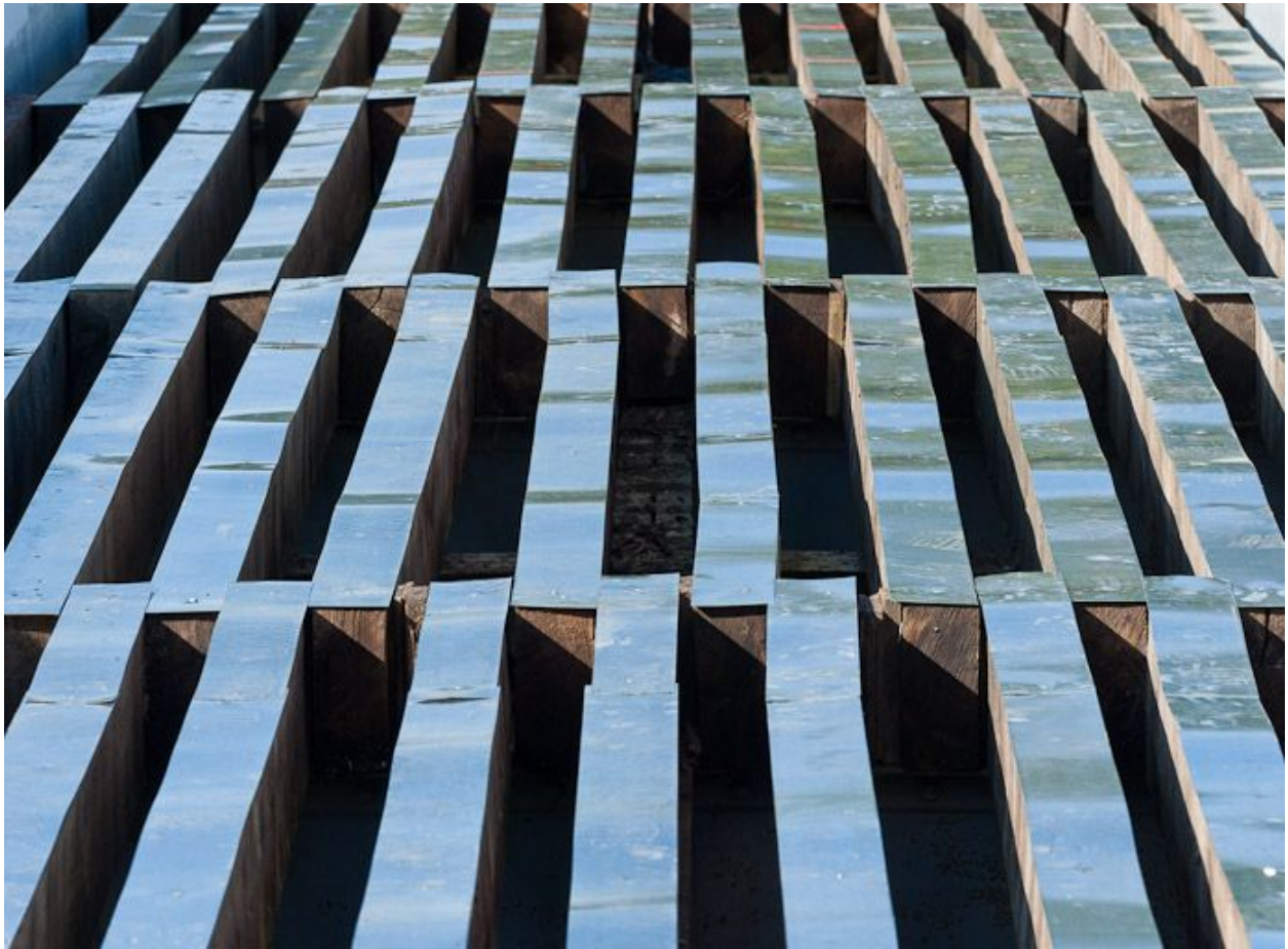
Détail du platelage.
