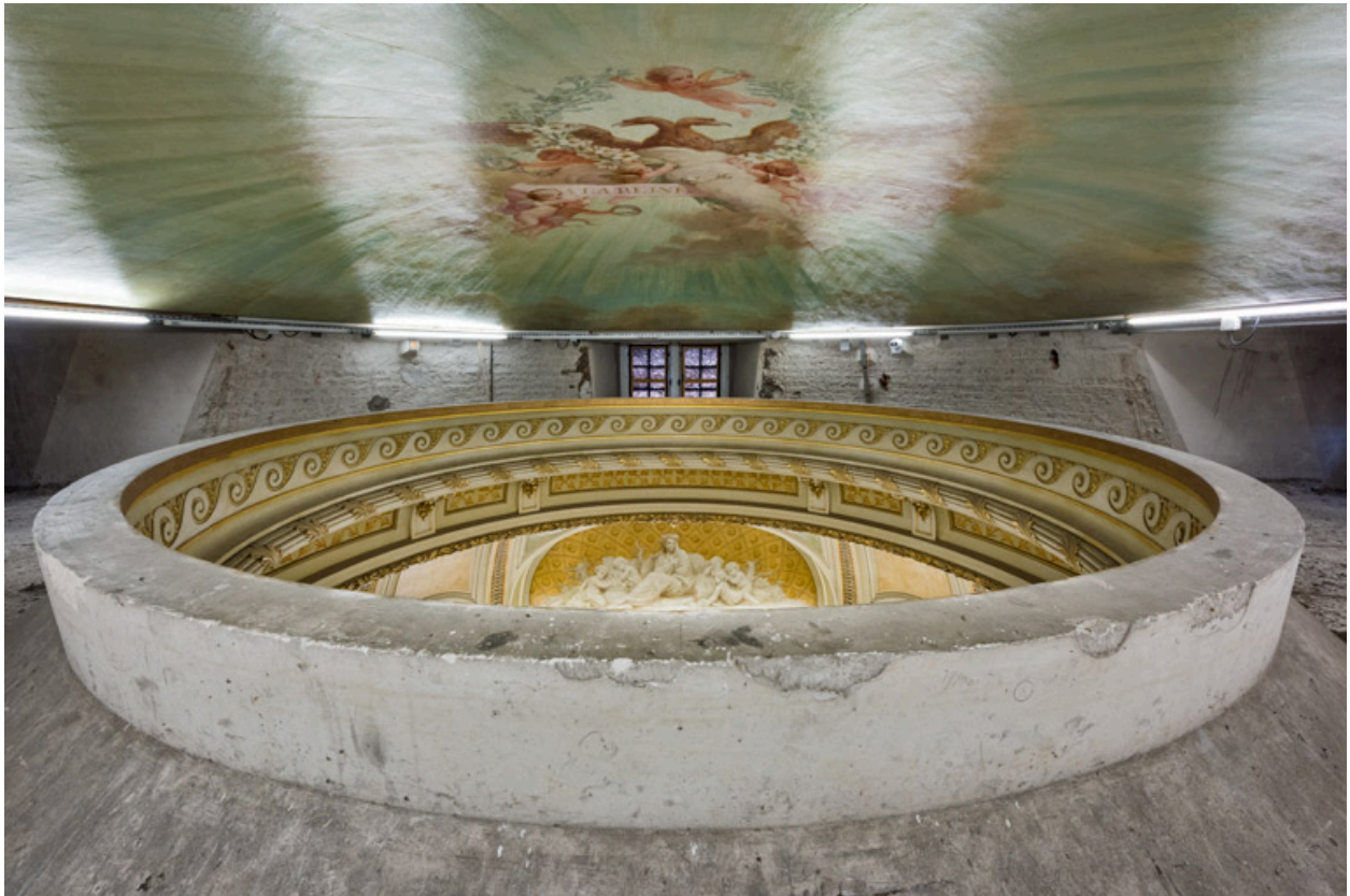
Oculus zénithal de la coupole et intrados peint de la calotte.
