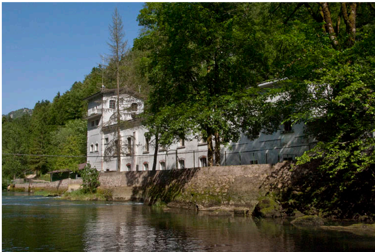
Centrale de la Goule : façade côté Doubs, vue de trois quarts droite.
