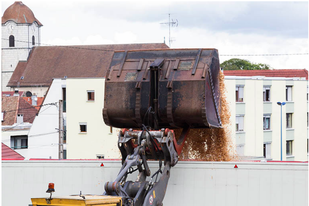
Silos à copeaux (B) : godet du chargeur.
