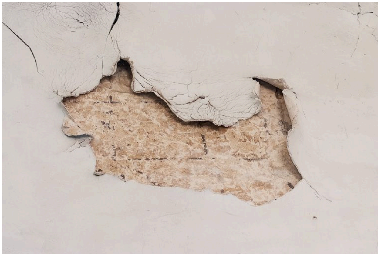
Détail de l'enduit du chœur.
