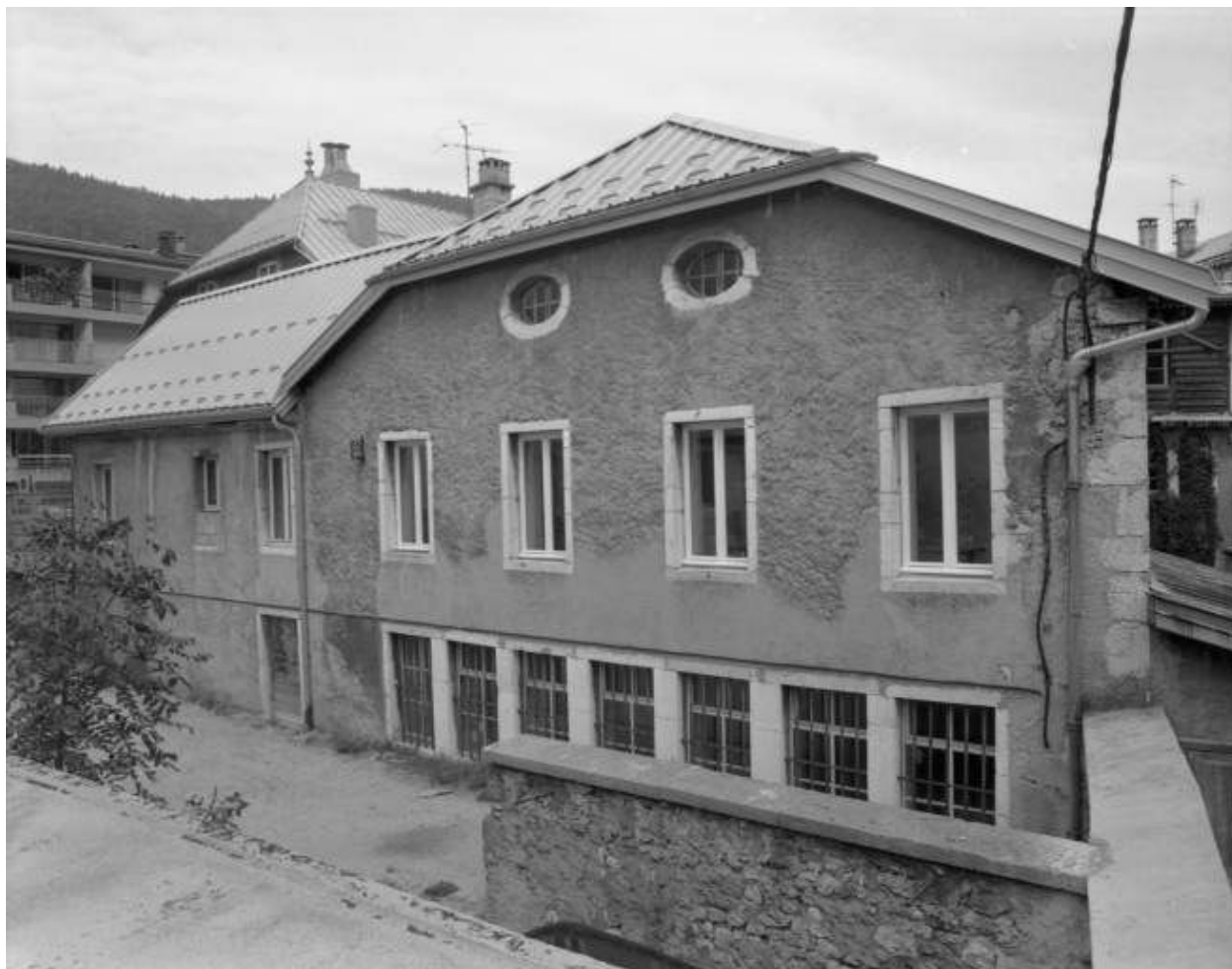
Façade latérale droite de l'usine.
