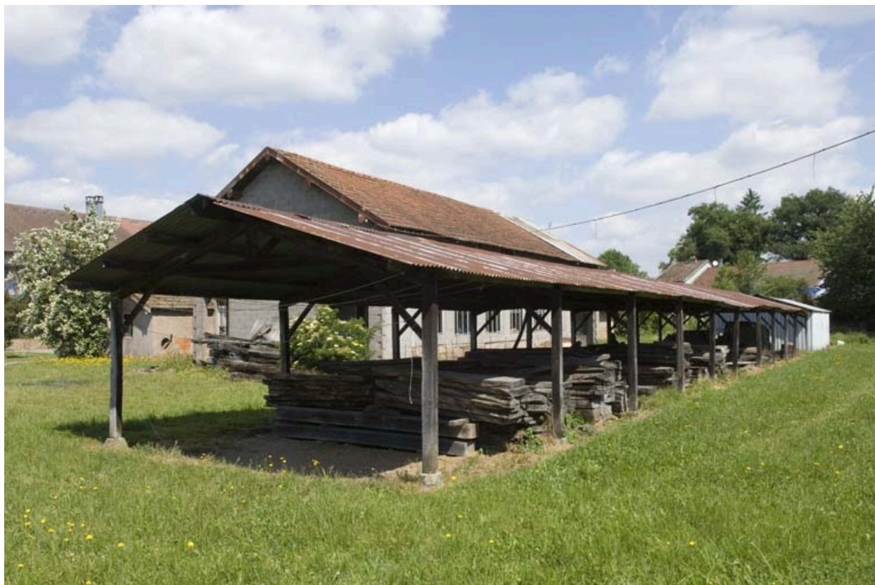
Usine de meubles Detrait, Saint-Loup-sur-Semouse (15 avenue de Conflans) : séchoir à bois.
