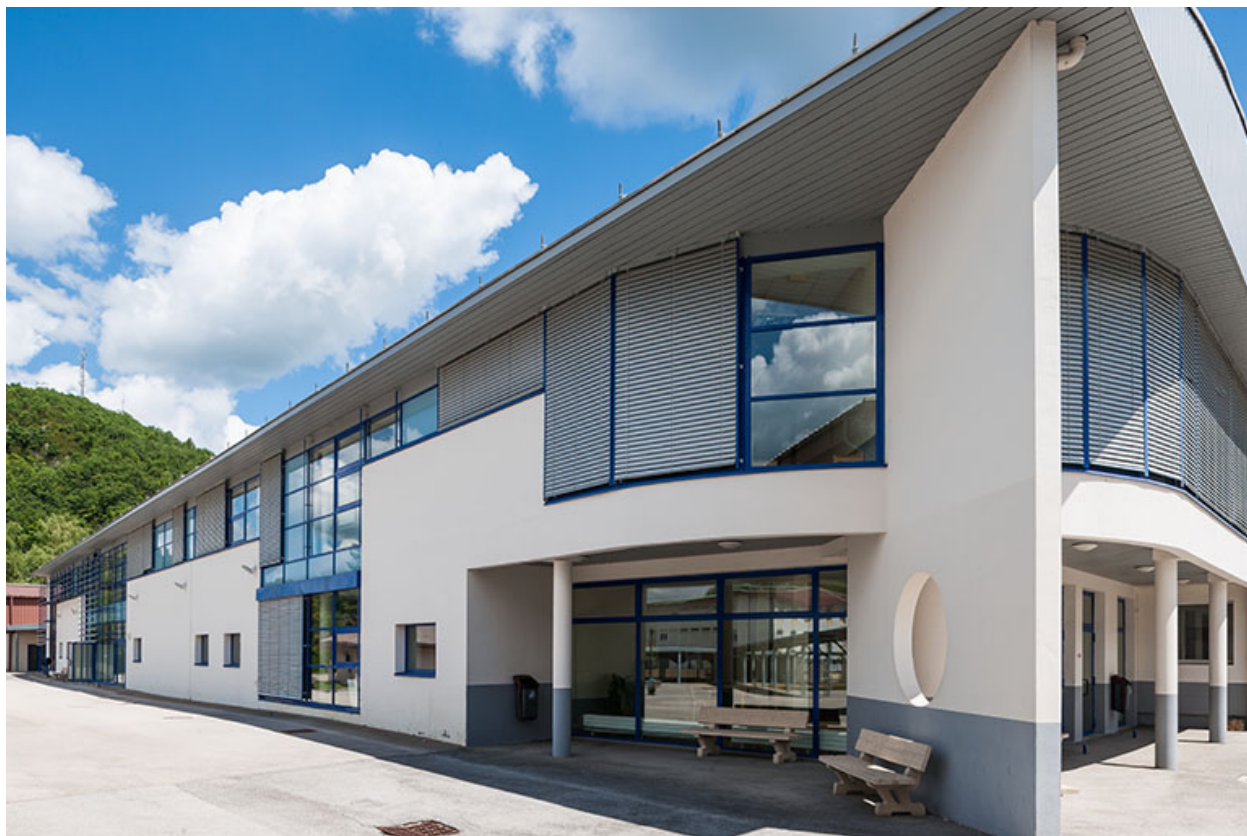
Ateliers : détail des façades et entrée.
