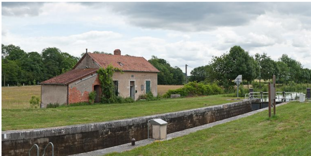
Vue d'ensemble du site d'écluse.
