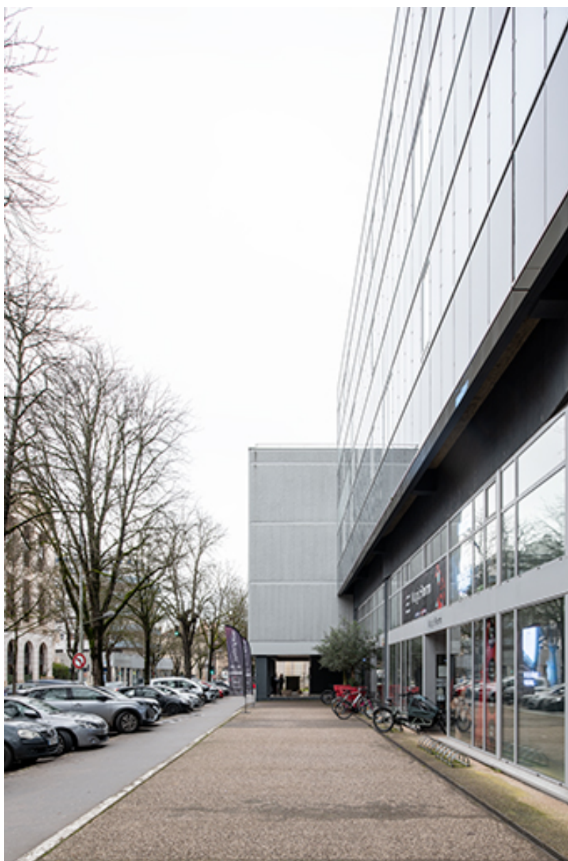
Façade nord-ouest, détail : avant-corps nord-est.
