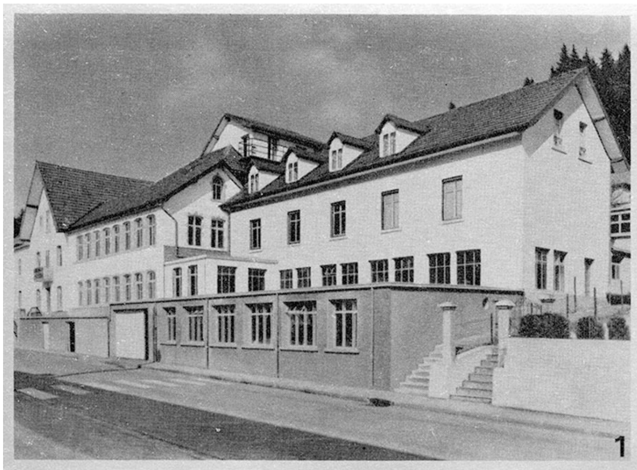
[France Ebauches] Usine n° 1 à Maïche [côté des numéros pairs], 1970.
