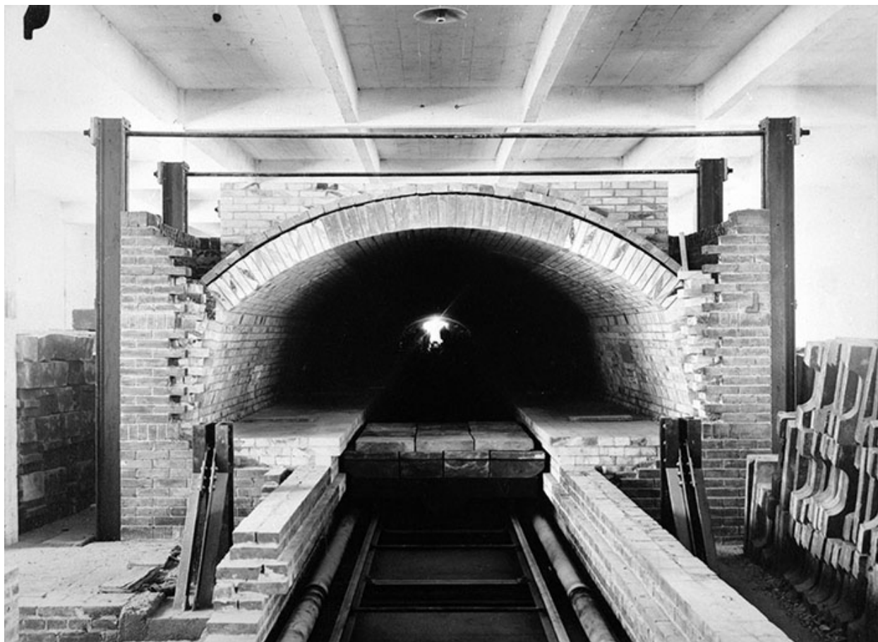
Four Dressler en construction : vue de face.
